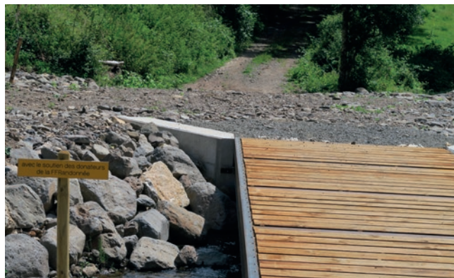
Rénovation de la passerelle sur le GR® 70 avec le soutien des donateurs
